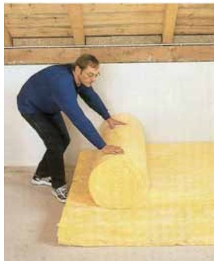
Slika 4.55 - Toplinska izolacija poda negrijanog potkrovlja
