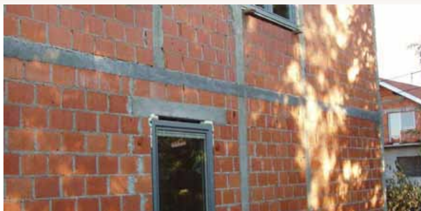
Slika 4.93 - Toplinski most prouzrokovan promjenom materijala
