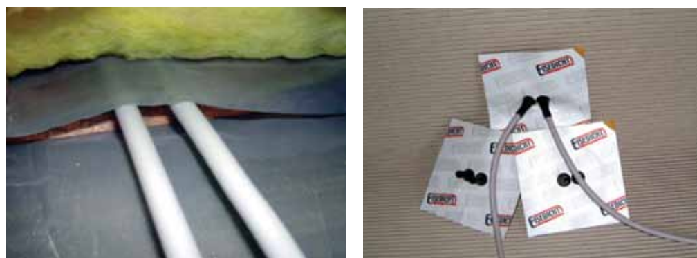
Slika 4.91 - Prolaz zaštitne cijevi elektroinstalacija kroz zrakonepropustan sloj (lijevo) i fazonski rukavci za brtvljenje elektroinstalacija (desno)
