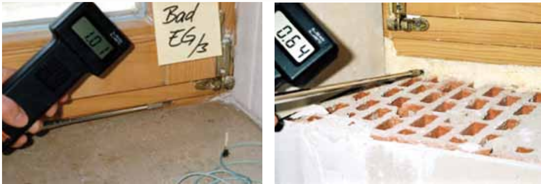
Slika 4.87 - Tipične greške izvedbe - zrakopropusnost reške oko prozora (lijevo) i strujanje zraka kroz šupljine u PU pjeni (desno) s brzinom strujanja zraka kroz reške
