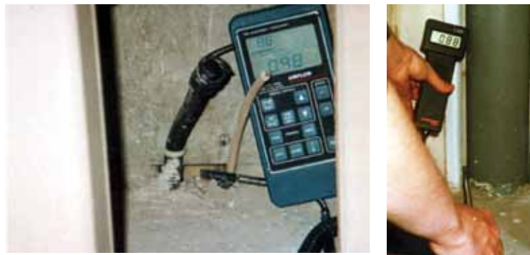
Slika 4.88 - Neobrađeni prodori uz instalacije
