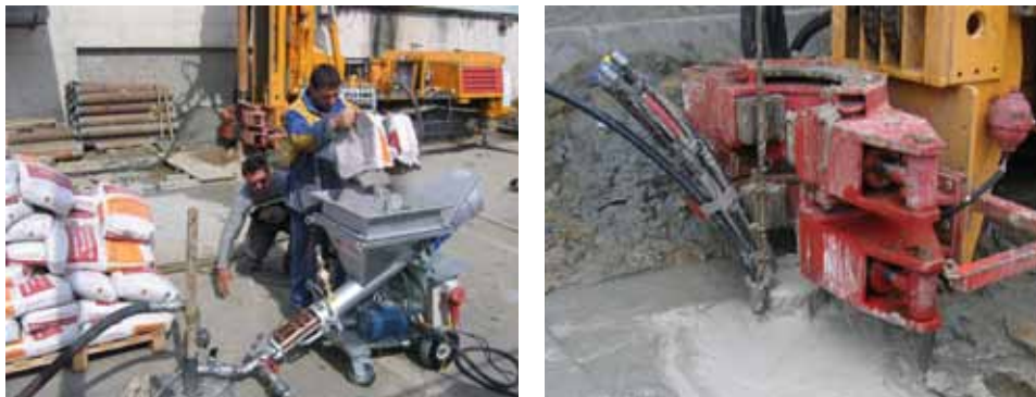
Slika 9.66 - a) Cementiranje bušotine; b) Završetak cementiranja
