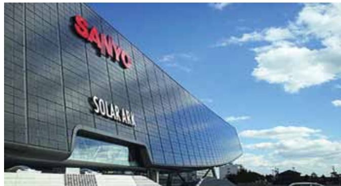
Slika 4.31 - Sanyo poslovna zgrada - Solar Ark, Gifu Prefecture, Japan, višefunkcionalni fasadni element s integriranim sustavom fotonaponskih modula od 630 kW, te proizvodnjom energije od oko 530.000 kWh godišnje
