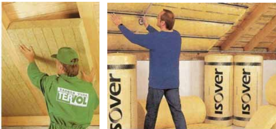
Slika 4.56 - Toplinska izolacija kosog krova grijanog potkrovlja
