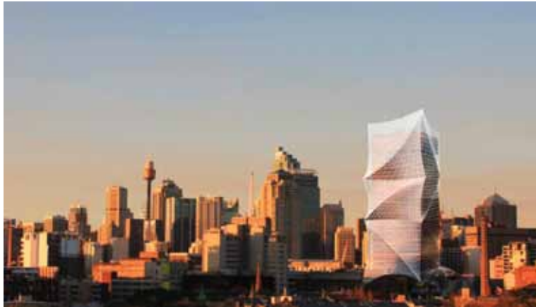
Slika 4.84 - Tekstilna obloga pročelja stvara zonu s povećanim strujanjem zraka ispred pročelja
