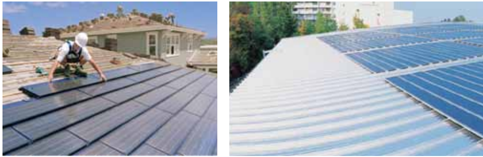
Slika 4.30 - Fotonaponski sustavi kao višefunkcionalni element pokrova
