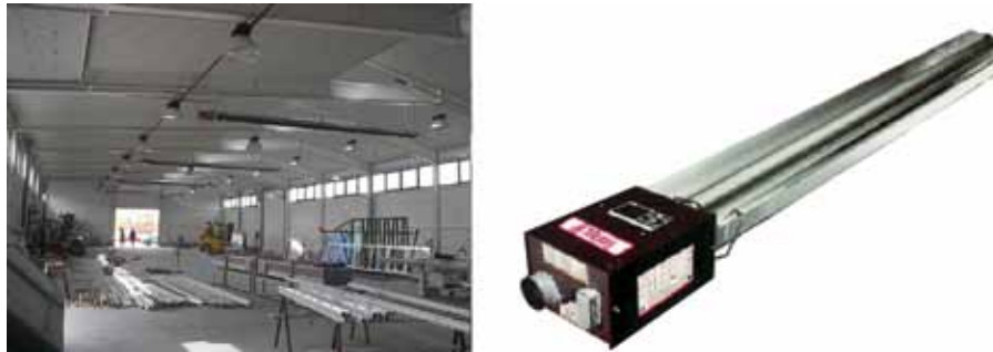
Slika 5.12 - Grijalica sa tamnim zračenjem
