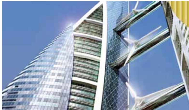
Slika 4.35 - Poslovna zgrada - World Trade Center Bahrain, (Atkins Design Studio)- tri vjetroagregata od 225 kW, promjera 29 m pokrivaju 15% energije dva poslovna tornja od 50 katova
