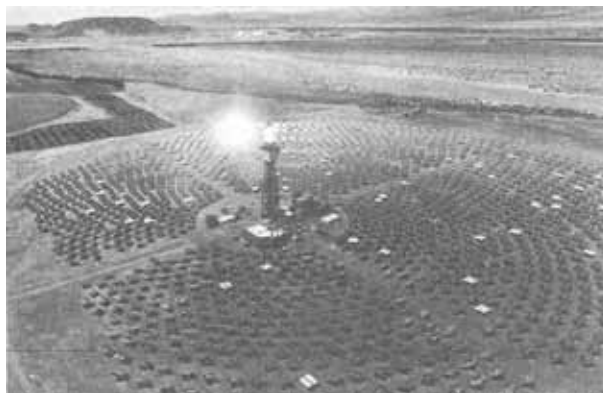
Slika 7.41 - Sunčev toranj (10 MWe) u južnoj Kaliforniji, 1818 heliostatskih zrcala [7.3]
