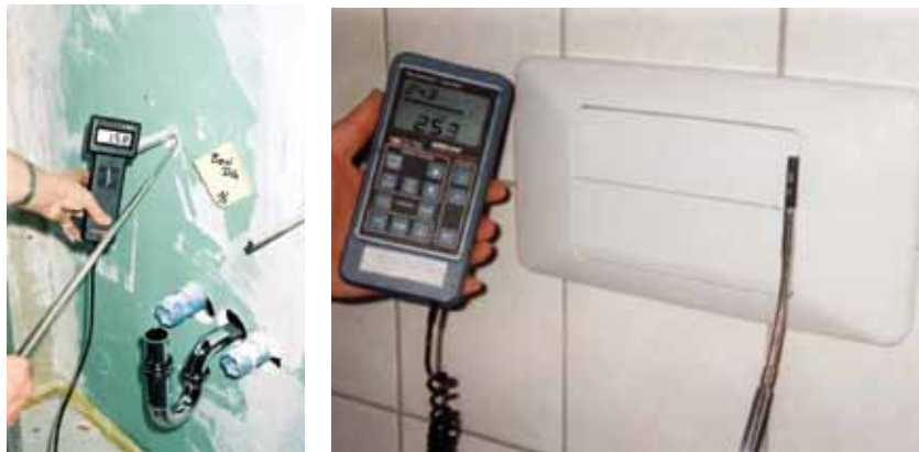
Slika 4.89 - Instalacijski zid nije zrakonepropustan - prodor zraka kroz tipkalo ugradnog vodokotlića
