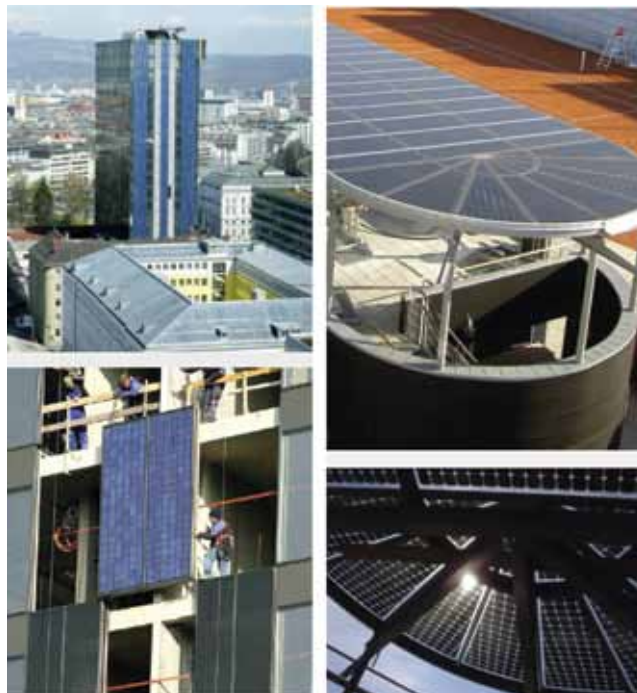
Slika 4.32 - Integrirani višefunkcionalni sustavi - Poslovna zgrada AG u Linzu, Austrija, 66 kW, te nadstrešnica u Bastadu, Švedska, 38,7 kW
