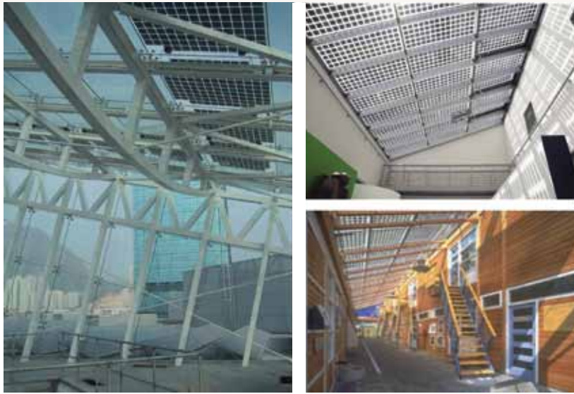
Slika 4.27 - Fotonaponski sustavi kao višefunkcionalni element transparentnih ploha pročelja
