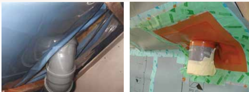
Slika 4.90 - Neobrađen i obrađen detalj prodora instalacije kroz krovšte
