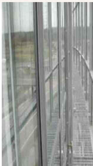
Slika 4.76 - Prirodno ventilirana dvostruka fasada
