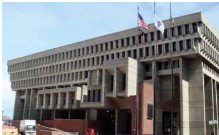
Slika 4.97 - Tipični toplinski mostovi prouzrokovani promjenom geometrije konstrukcije
