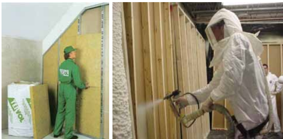
Slika 4.57 - Toplinska izolacija laganih zidova prema negrijanom prostoru
