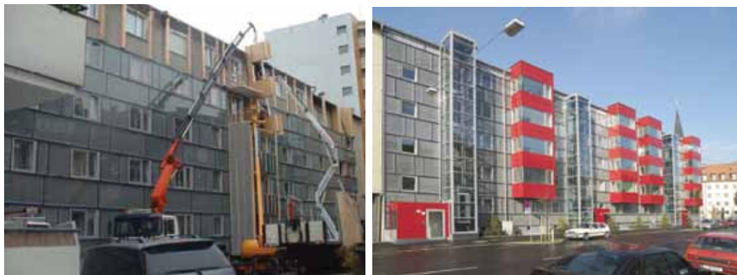
Slika 4.11 - Zgrada u fazi rekonstrukcije i po završetku
