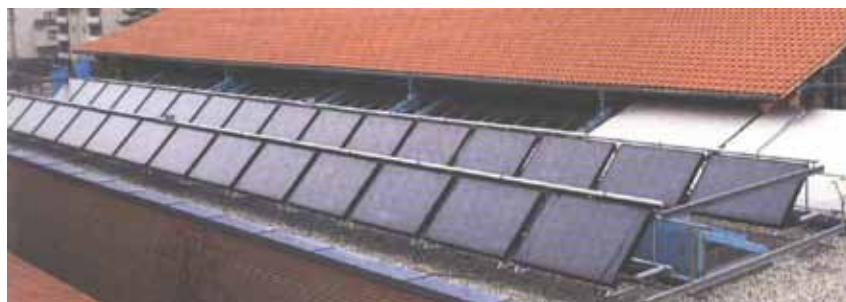
Slika 7.51 - Sunčani sustav s grupama kolektora montiranih na krovne nosače
