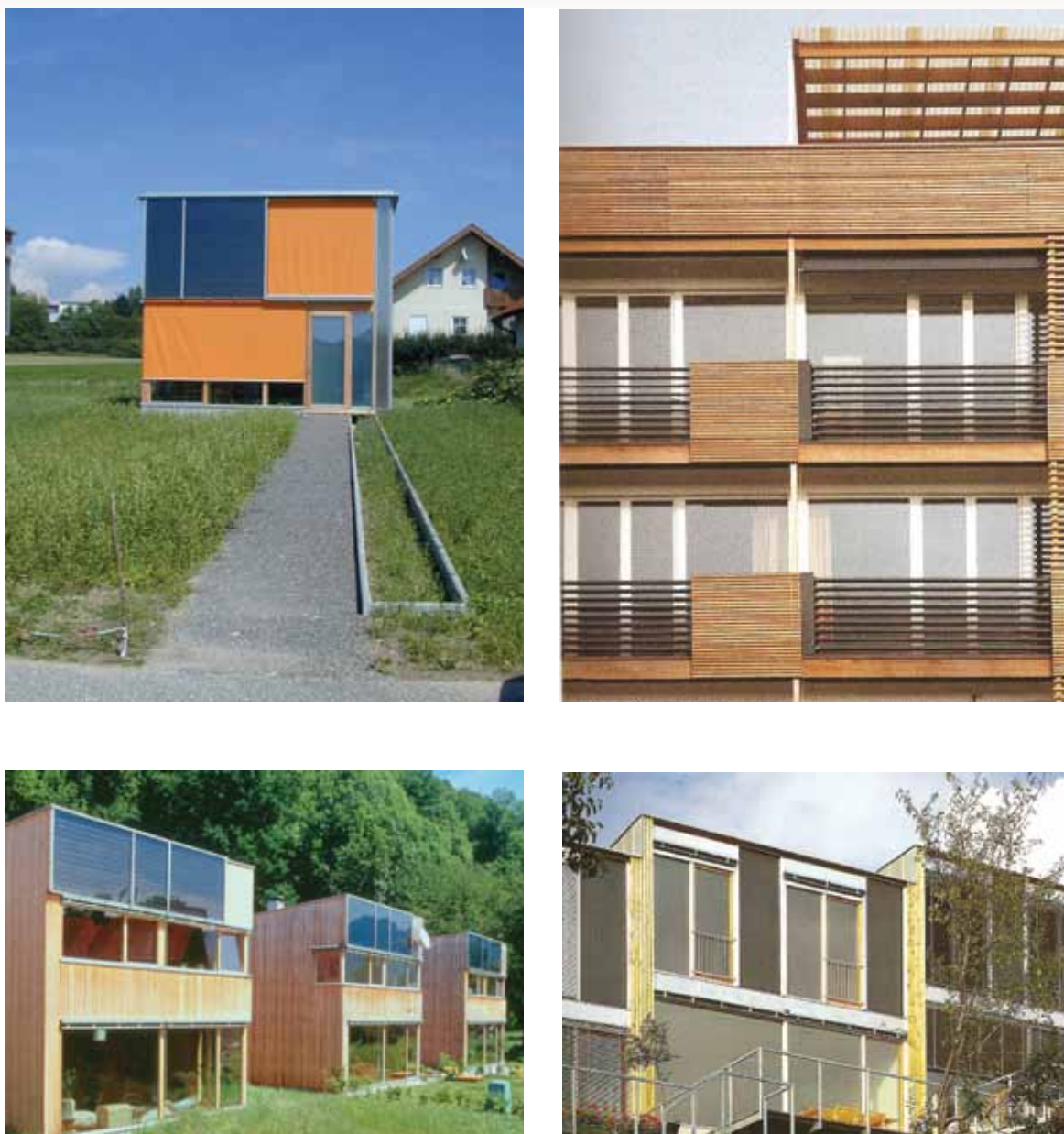
Slika 4.25 - Sunčani sustavi za grijanje i PTV integrirani u elemente pročelja i ograde terase
