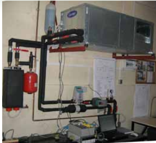
Slika 9.67 - Dizalica topline voda-zrak s mjernom opremom
