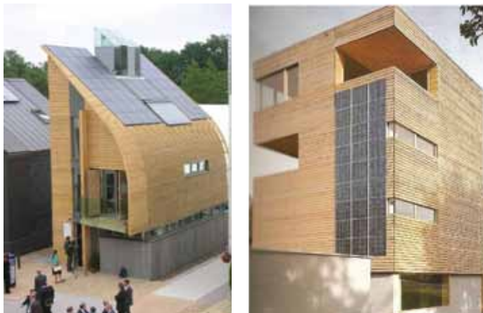
Slika 4.29 - Fotonaponski sustavi kao višefunkcionalni element zaštite od sunca
