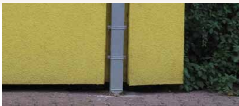
Slika 4.95 - Toplinski most prouzrokovan promjenom debljine konstrukcije
