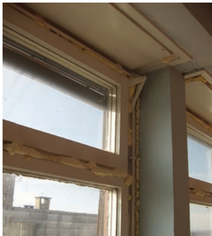
Slika 6.24 Brtvljenje reški otvora poliuretanskom pjenom
