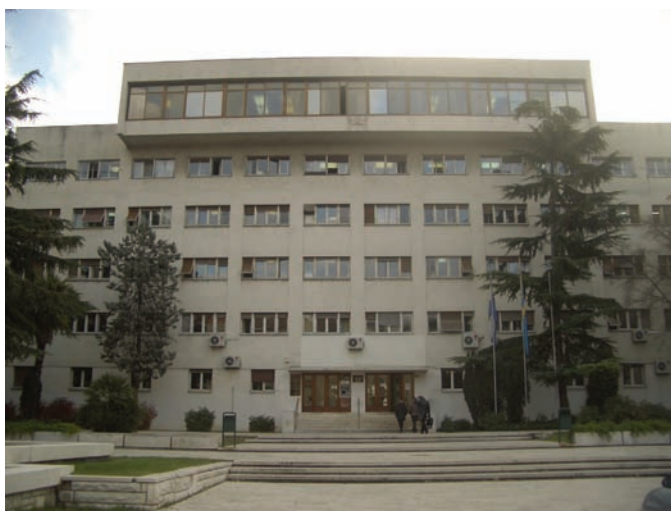
Slika 6.18 Zgrada Splitsko-dalmatinske županije, Split
