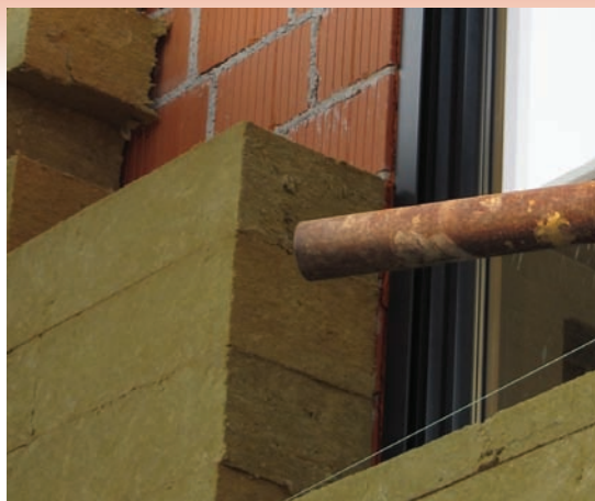
Slika 5.10 Izvedba toplinske izolacije vanjskog zida nisko energetske zgrade U = 0,15 \text{ W/m}^2\text{K} .
