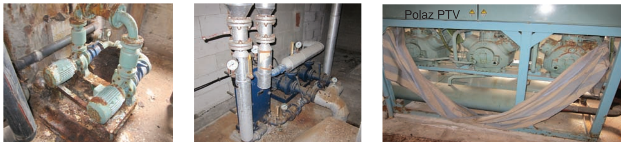
Slika 6.79 Pumpe morske vode, izmjenjivač topline potrošne tople vode i kompresori dizalice
