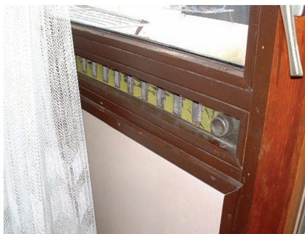
Slika 6.89 Otvor za provjetravanje sobe na okviru prozora starije izvedbe
