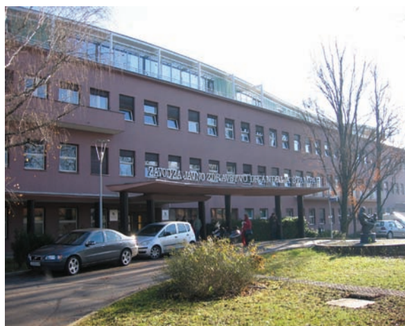
Slika 6.49 Pročelje zgrade I Zavoda za javno zdravstvo Dr. Andrija Štampar tijekom energetskog pregleda
