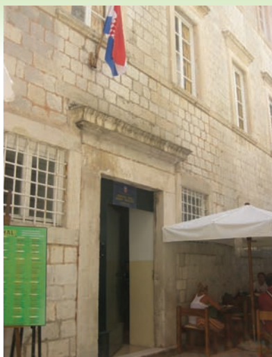
Slika 6.30 Glavna zgrada Osnovne škole Marina Getaldića
