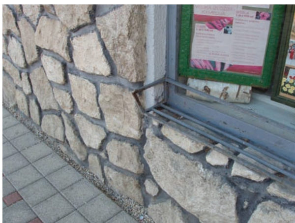
Slika 6.43 Mješoviti zid -vanjski sloj od lomljenog kamena
