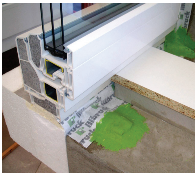
Slika 5.12 Detalj ugradnje prozora - brtvene trake za smanjenje zrakopropusnosti
