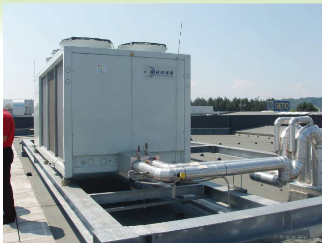
Slika 6.140 Rashladnik proizvođača RHOSS tip TCEASY 4320
