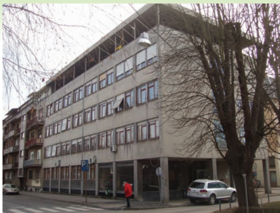
Slika 6.22 Sjeverno pročelje zgrade Dunavskog Lloyd
