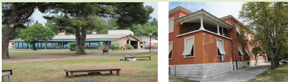
Slika 6.72 Kuhinja i restoran (lijevo) i Odjel IV (desno)
