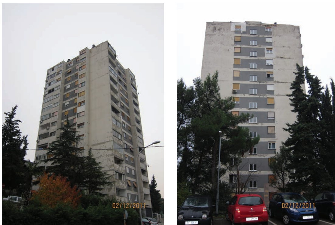
Slika 6.12 Zapadna i sjeverna fasada
