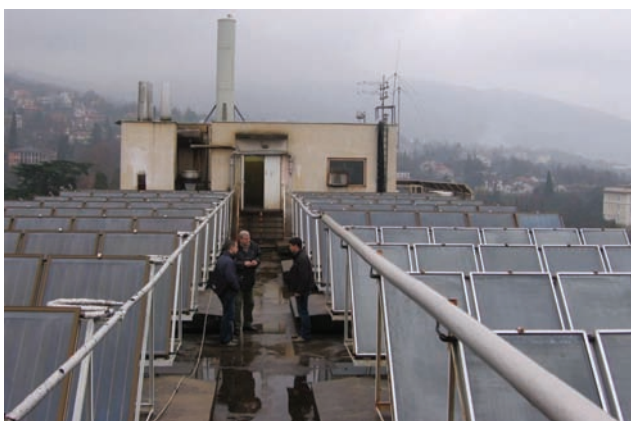
Slika 6.98 Sunčevi kolektori smješteni na krovu zgrade
