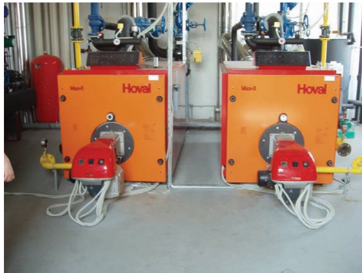
Slika 6.137 Instalirani niskotemperaturni kotlovi HOVAL tipa MAX 3 na prirodni plin
