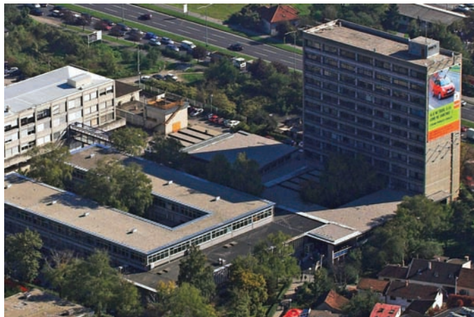
Slika 6.27 Južna zgrada Fakulteta strojarstva i brodogradnje, Sveučilišta u Zagrebu
