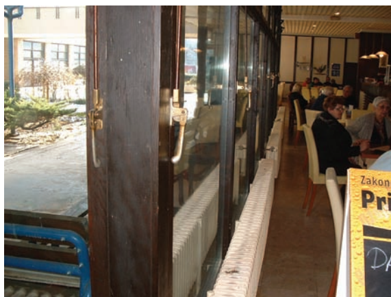
Slika 6.90 Niz radijatora ugrađenih neposredno uz staklenu vanjsku plohu
