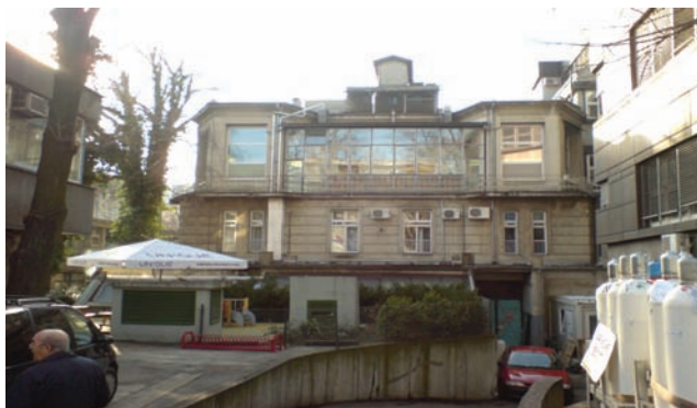
Slika 6.63 Otvori za usis zraka iz operacijskih sala
