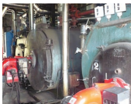
Slika 6.73 Kotlovnica (lijevo), toplovodni i parni kotlovi u kotlovnici (desno)
