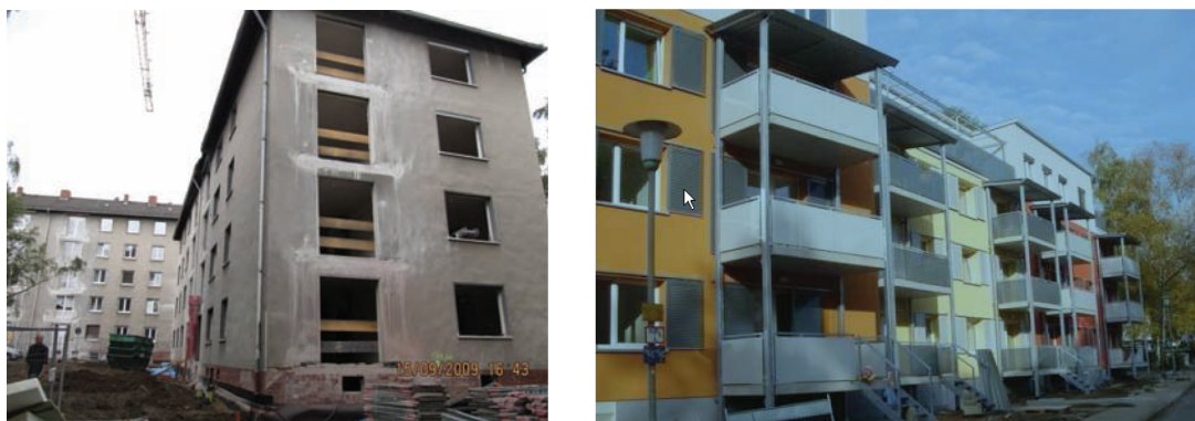
Slika 5.16 Primjer sanacije toplinskih mostova kod betonskih konstrukcija balkona pri energetske obnove zgrade
