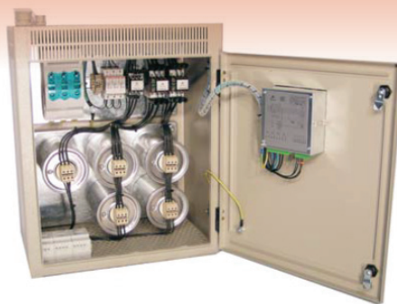
Slika 5.50 Razdjelni ormar postrojenja automatske kompenzacije jalove snage
