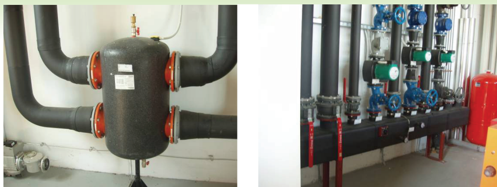
Slika 6.138. Toplinski izolirana hidraulička skretnica, te razdjelnik/sabirnik podsustava razvoda toplinske energije - za cjelokupni objekt
