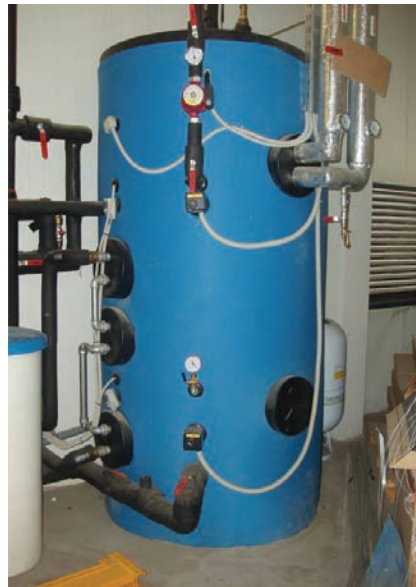
Slika 6.141 Rashladnik unutar skladišta i spremnik PTV-a V= 2.000 litara
