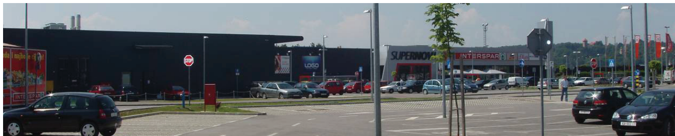
Slika 6.134 Sjeverno pročelje TC Supernova Karlovac – objekt A
