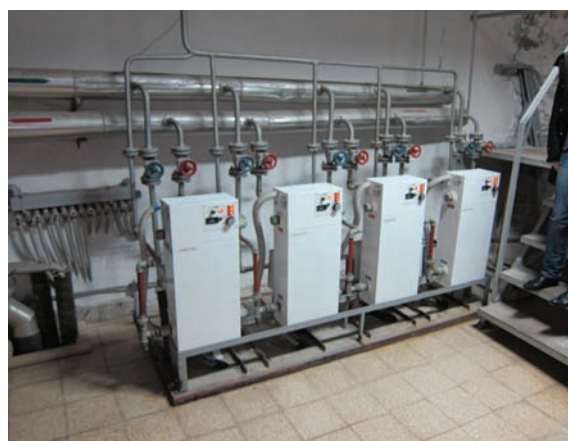
Slika 5.22 Toplovodna kotlovnica
