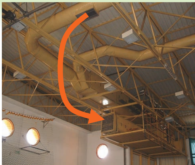
Slika 6.118 Kratka veza kod strujanja zraka u dvorani [1]
