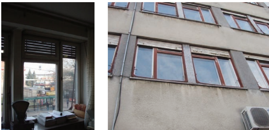
Slika 6.23 Karakteristični drveni jednostruki prozor s dvostrukim ostakljenjem
