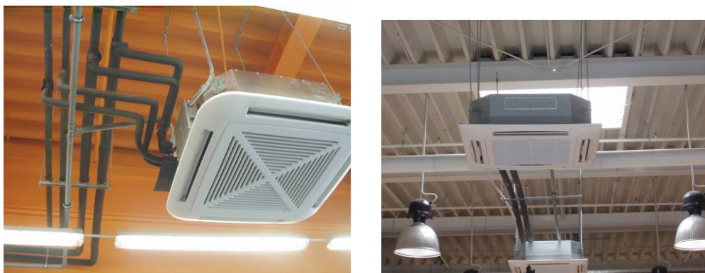
Slika 6.139 Ventilokonvektori u prostorima objekta Supernova
