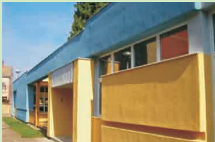
Slika 3.30. Zgrada prije rekonstrukcije, vizualizacija mogućeg izgleda, te zgrada danas nakon rekonstrukcije
