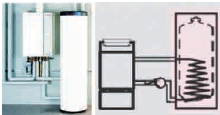
Slika 6.9. Centralna priprema vode s kotlom i indirektno grijanim spremnikom
