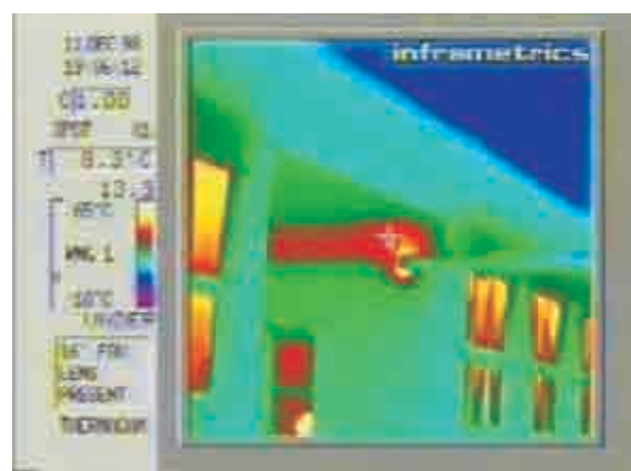
Slika 3.22. Karakteristični primjeri toplinskih mostova na neizoliranim zgradama/ Izvor EIHP
