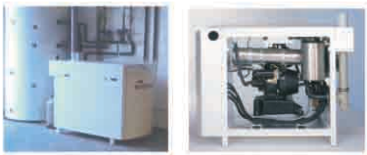
Slika 7.27. Plinski kogeneracijski uređaj
