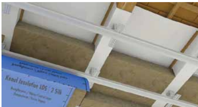
Slika: Primjer sanacije kosog krova iznutra
