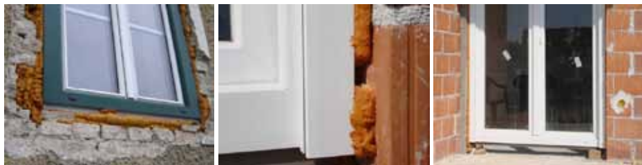
Slika: Primjeri nepravilno ugrađenih prozora
